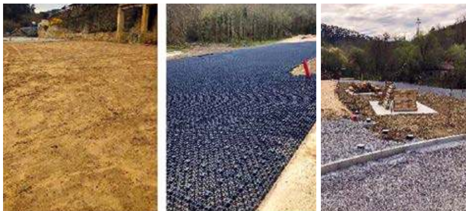
Instalación de las celdas de polipropileno.
