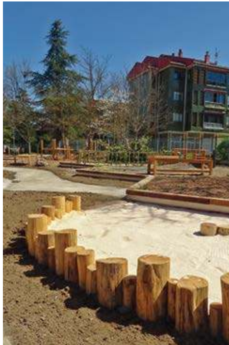
Aporte de tierra vegetal en las zonas despavimentadas.
