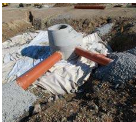
Arqueta de acceso en fase construcción.
