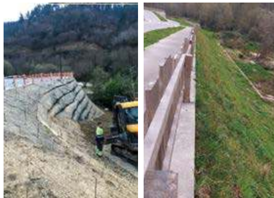
Estabilización de talud con bioingeniería durante la obra (superior e inferior izquierda) y después de medio año (inferior derecha).
