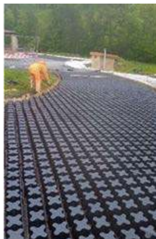
Puesta en obra de las losas de hormigón perforadas para los viales de tráfico rodado.
