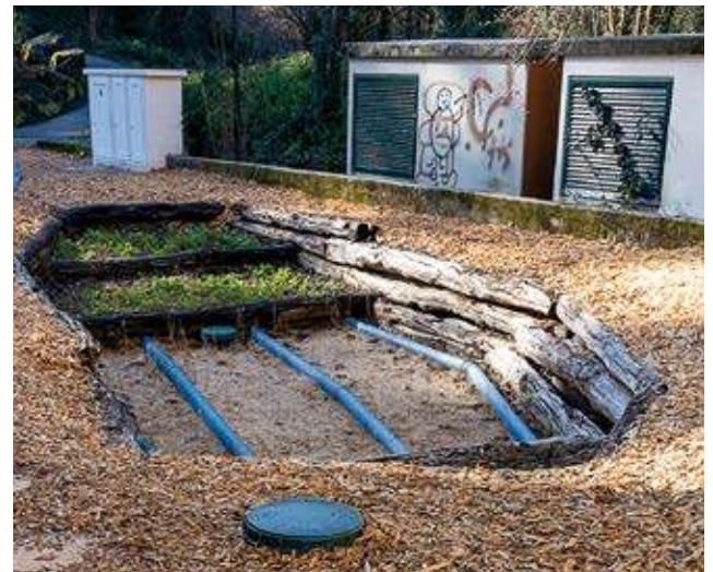
Aspecto general del estanque artificial ejecutado.
