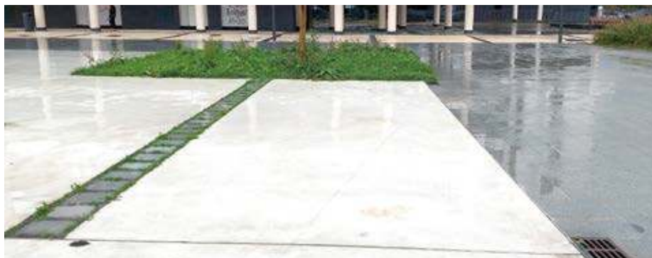
Franja drenante (izquierda) una vez finalizada la obra y arqueta convencional de recogida de pluviales (derecha)
