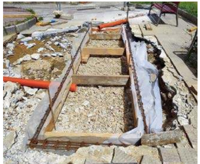
Excavación del terreno y colocación de geotextil.
