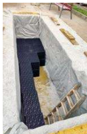
Relleno con estructuras reticulares y grava.
