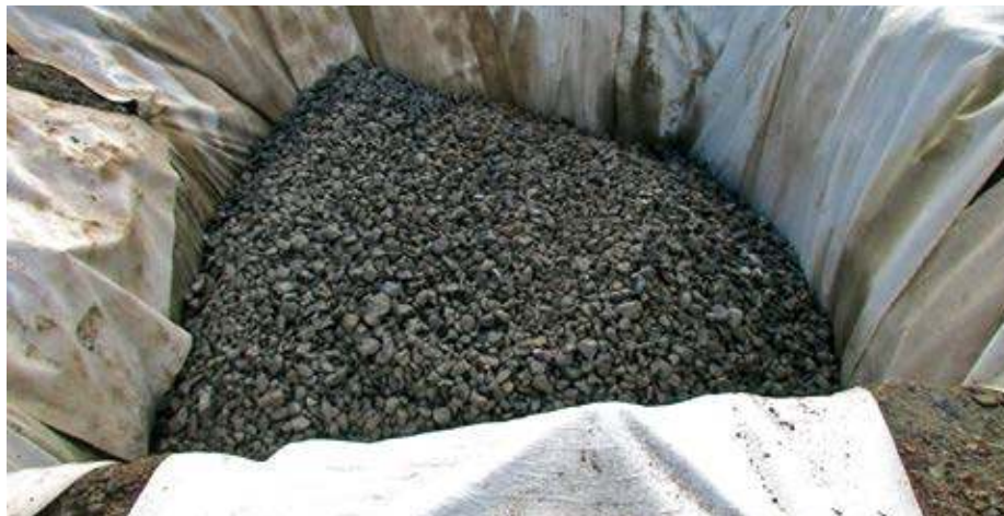
Columna de grava de 6 m de profundidad para los pozos de infiltración que asegura el drenaje.
