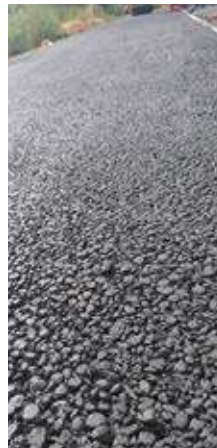
Hormigón poroso continuo para aceras.
