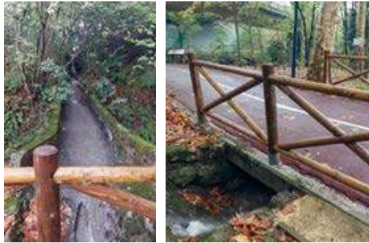
Cuneta lateral para la recogida de agua de escorrentía de la A8.
