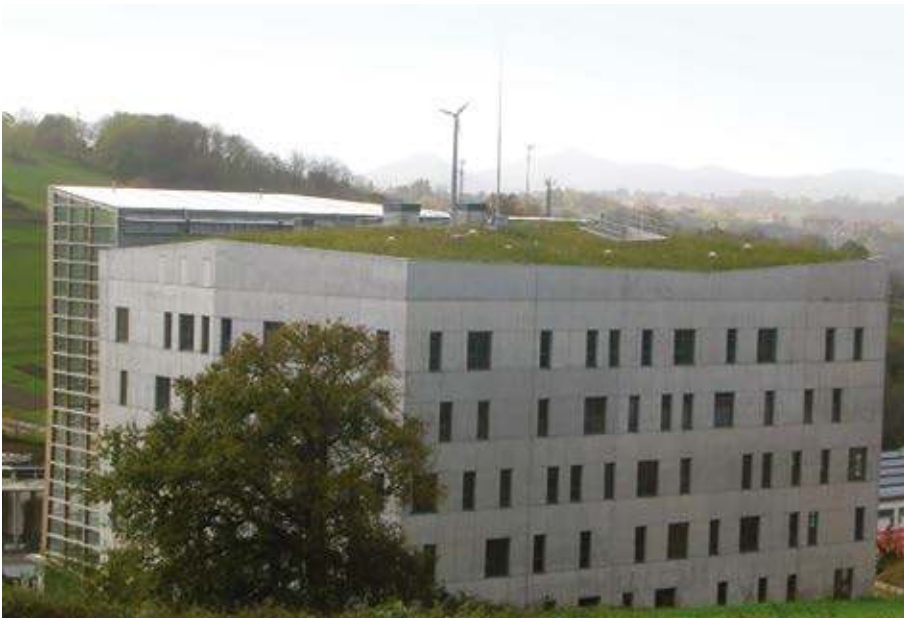
Cubierta vegetada de ENERTIC.
