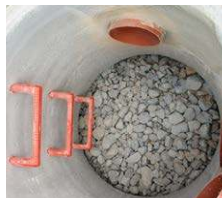
Arqueta de acceso una vez finalizada la obra.
