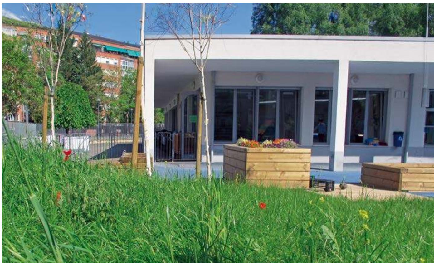
Vista general del patio tras la finalización de los trabajos.
