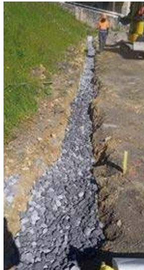
Construcción de la zanja filtrante (imagen izquierda). Zanja filtrante con vegetación una vez finalizada la obra (imagen derecha).
