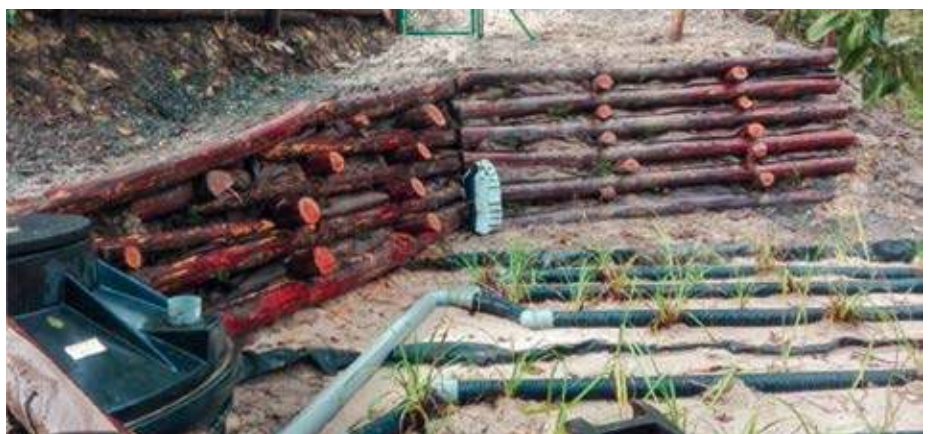
Ejecución de muro permeable para la estabilización de la ladera.
