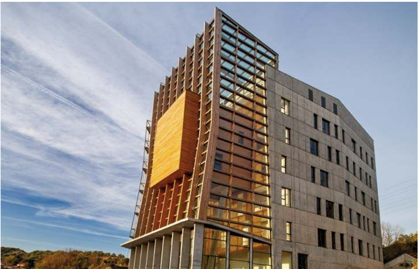
Vista exterior del edificio ENERTIC.
