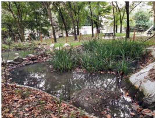
Cuneta lateral para la recogida de agua de escorrentía de la A8.
