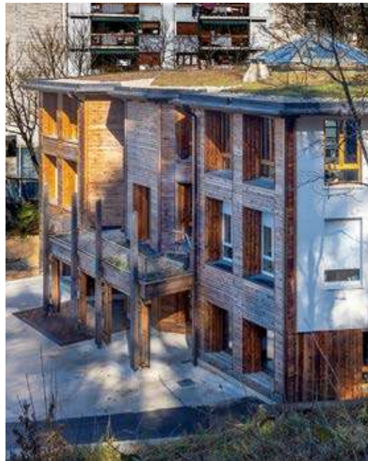
Exterior de la Eskola y fachada natural ejecutada.
