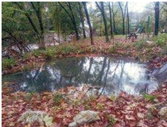
Balsas de fitodepuración conectadas (arriba balsa filtro de gravas y helófitos, y abajo balsa humedal).
