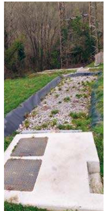
Sistema de fitodepuración y arqueta de separación de grasas.
