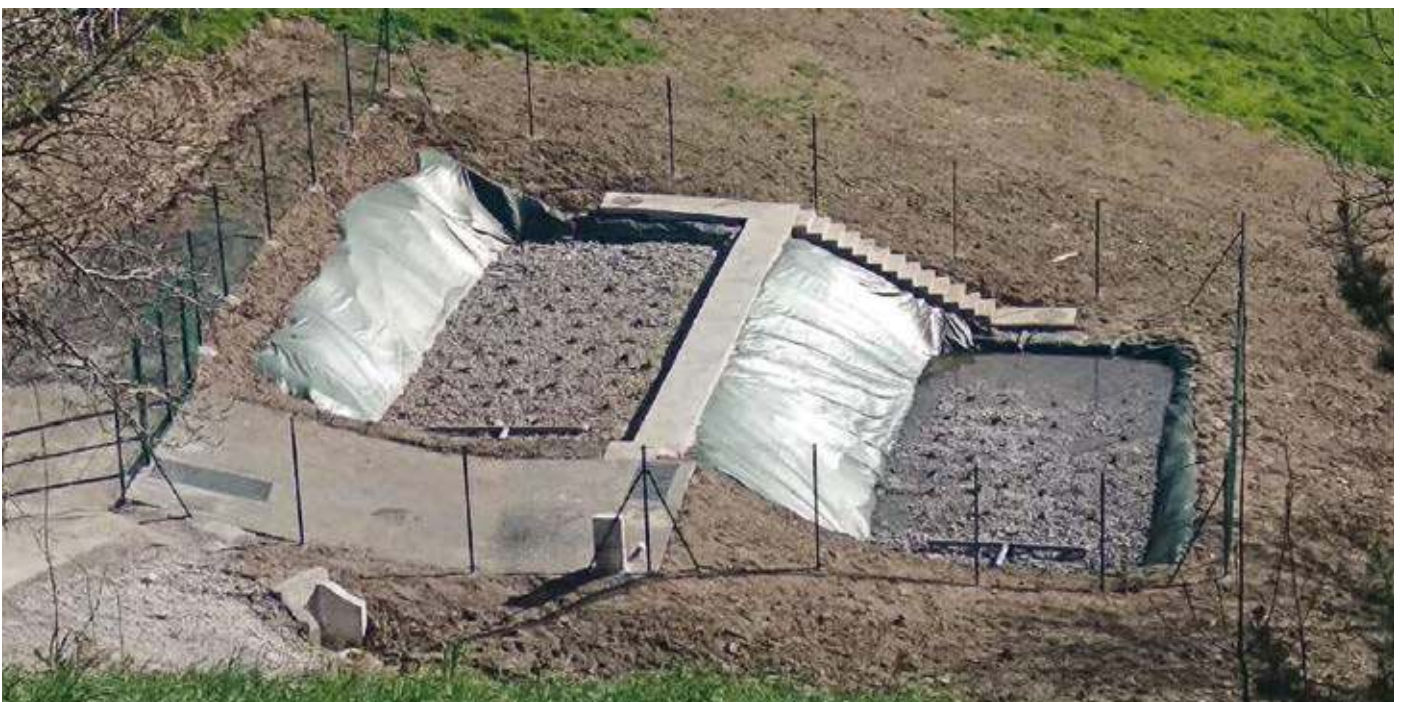
Vista general del humedal artificial de flujo horizontal sub-superficial con macrófitas ejecutado en el Barrio de Merru.
