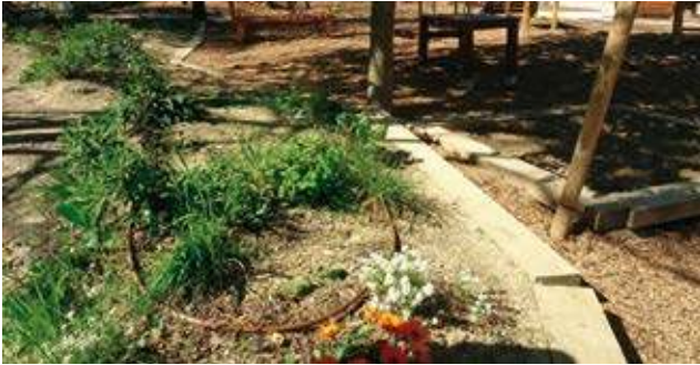
Riego por goteo conectado al sistema de recogida de pluviales.
