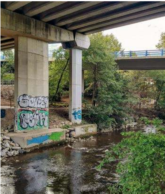
Viaducto en el que se ubican algunas de las intervenciones.
