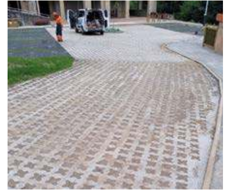
Celosía de hormigón ejecutada para los viales de tráfico rodado.
