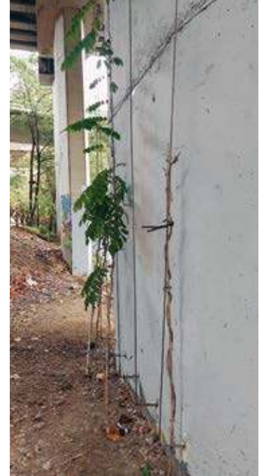
Cables anclados al pilar con una separación.
