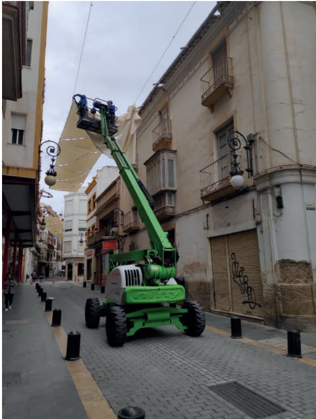
Ilustración 2. Montaje del corredor de sombra. Fuente: Ayuntamiento de Lorca
