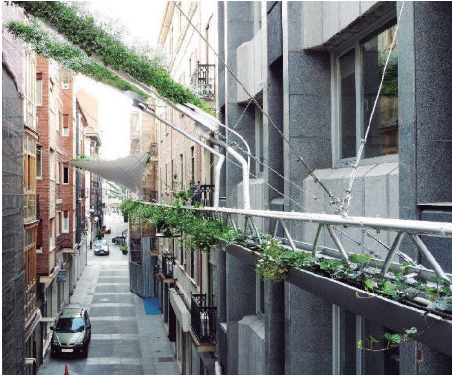
Figura 12. Viga central de celosía de aluminio. Fuente: Singular Green
