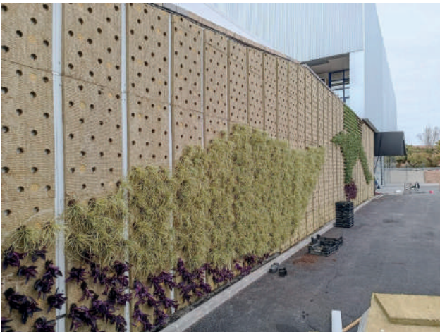
Ilustración 2. Jardín vertical en fase de obras y tras su instalación. Fuente: Agustín Torres Jerez (AQUATEC).
