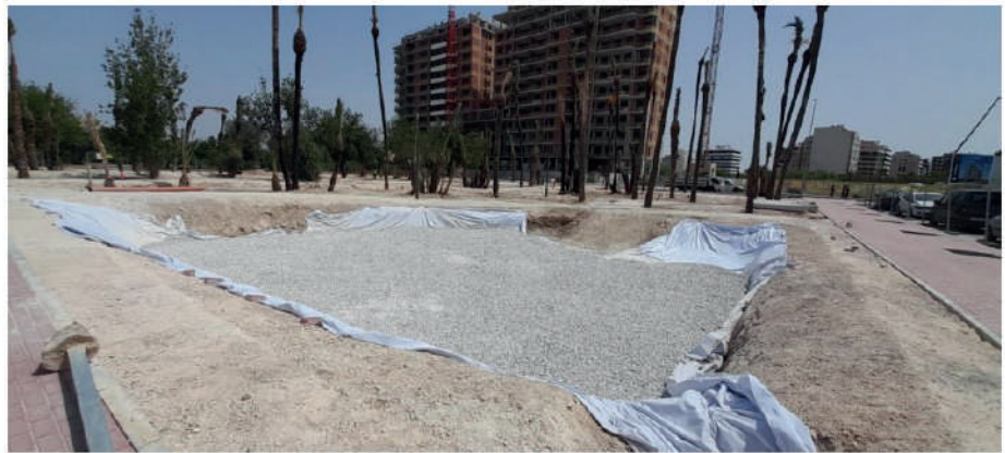
Ilustración 3. Construcción de los SUDS del proyecto de urbanización. Fuente: Ayuntamiento de Murcia
