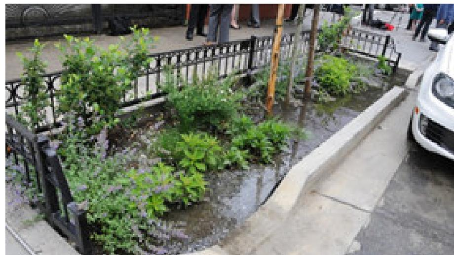
FIGURA 8: EJEMPLOS DE PARTERRES INUNDABLES SIN RIEGO.
