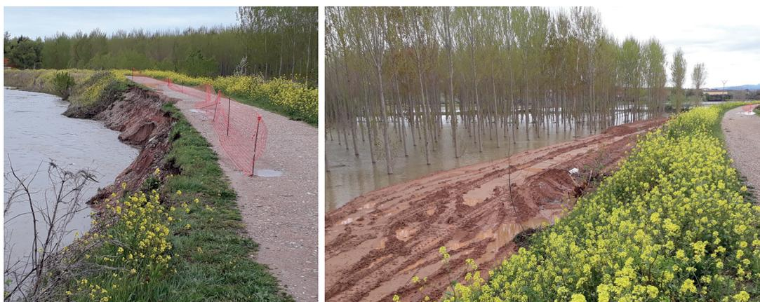
Figura 31. Ejemplo de erosión (izquierda) y obras de restauración y protección (derecha) en el margen del río Alhama en Alfaro (La Rioja) (pozos al fondo de la imagen).
