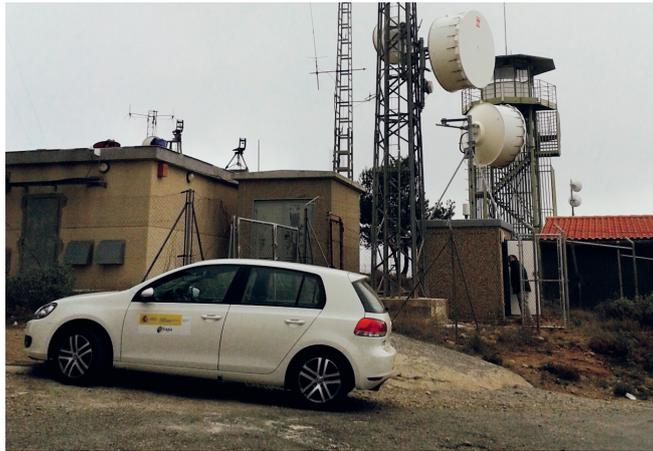
Figura 11. Ejemplo de elementos de la red de telecomunicaciones: radioenlace.
