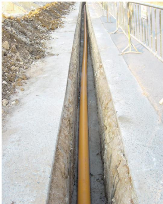
Figura 16. Ejemplo de tubería de distribución de gas.
