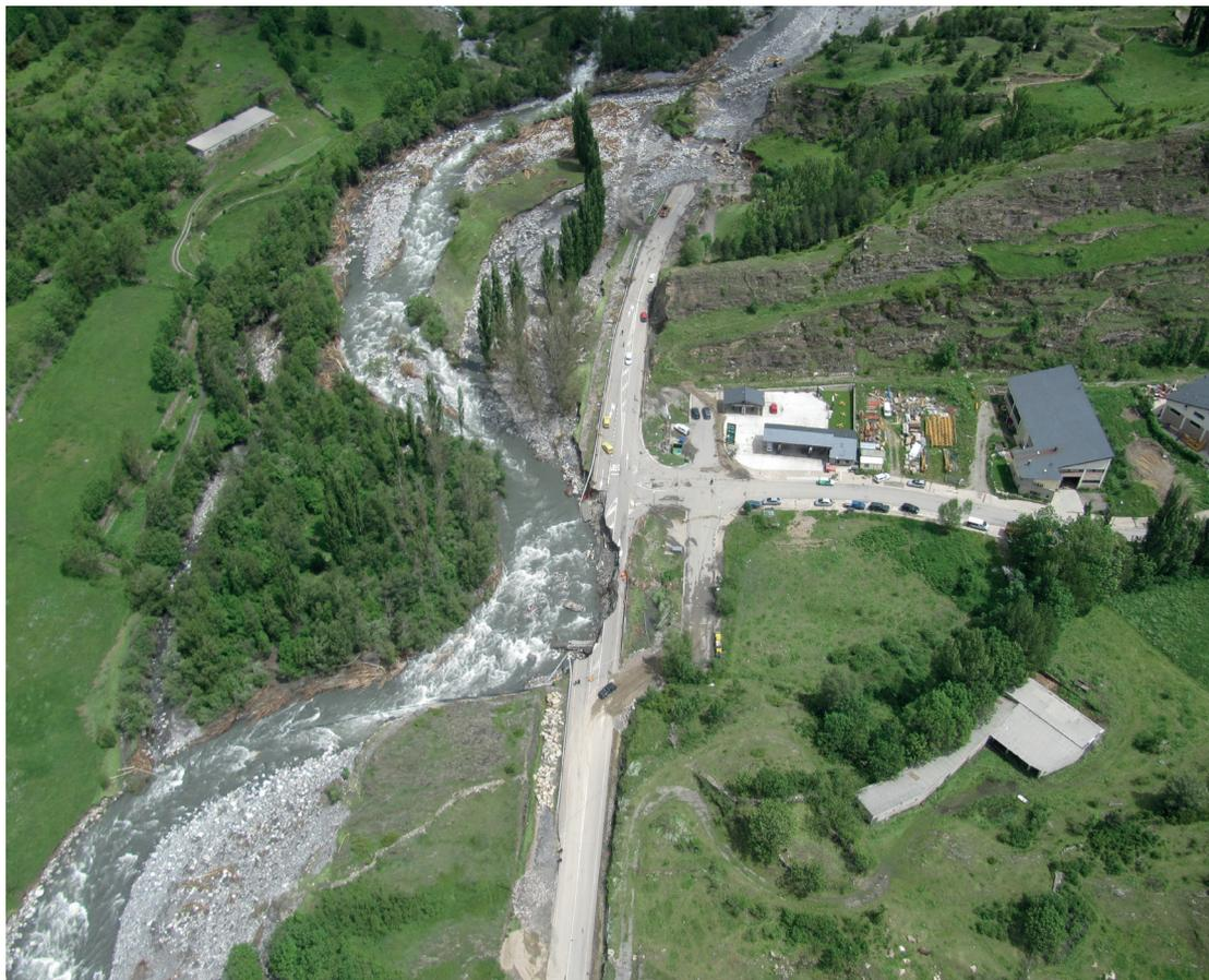
Figura 24. Destrucción de carretera por inundación por las crecidas del río Ésera en el valle de Benasque (Huesca) (2014).
