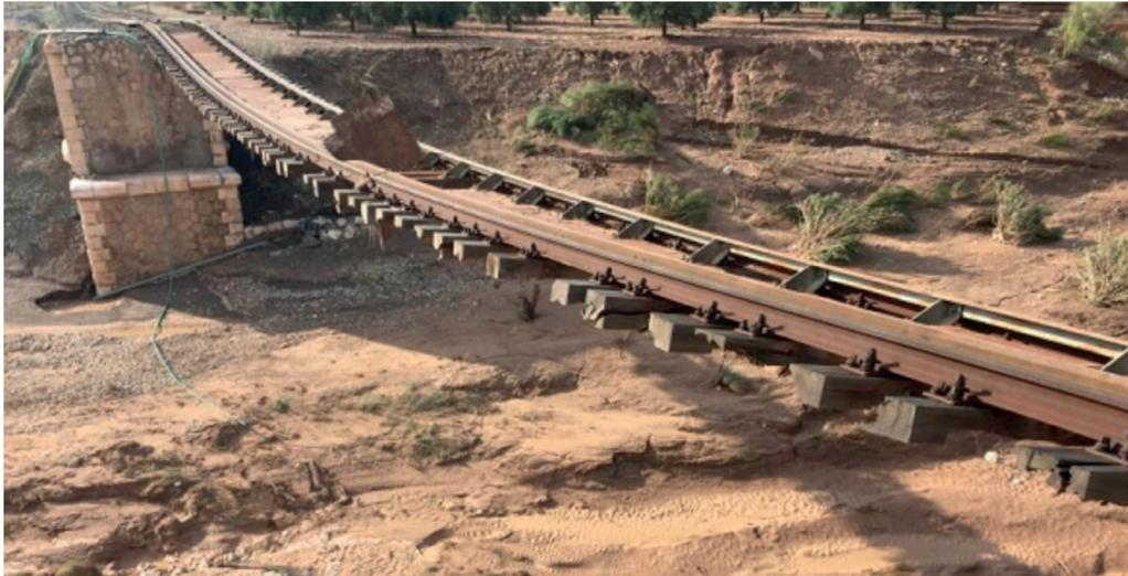
Figura 21. Daños en red de ferrocarril en Agudulce (Sevilla) por inundación (2018).
