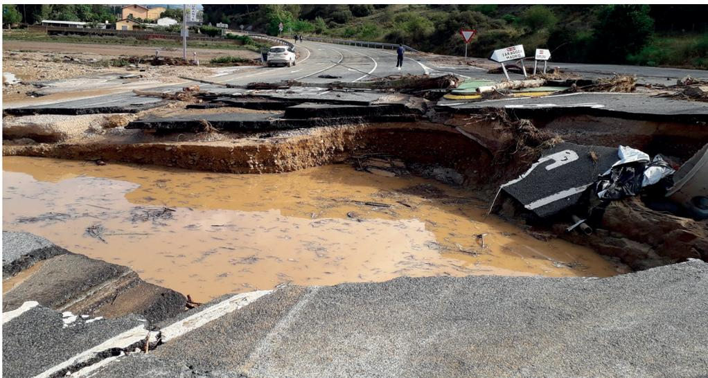
Figura 23. Daños en carretera en Pueyo (Navarra) por inundación (2019).
