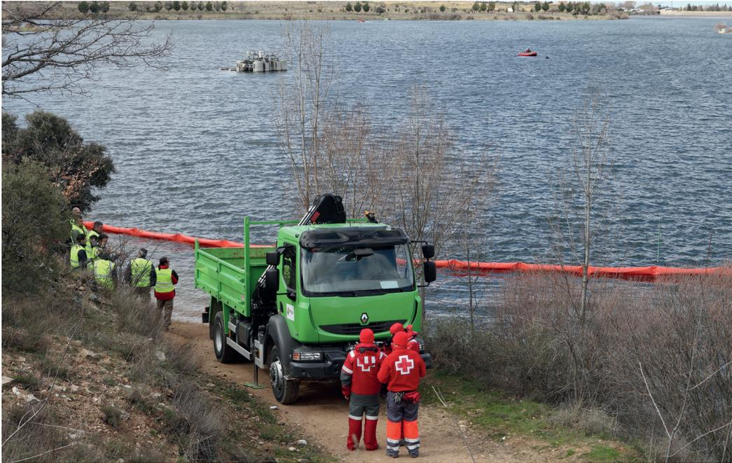
Figura 17. Simulacro de vertido: ejemplo de barrera de contención de hidrocarburos.
