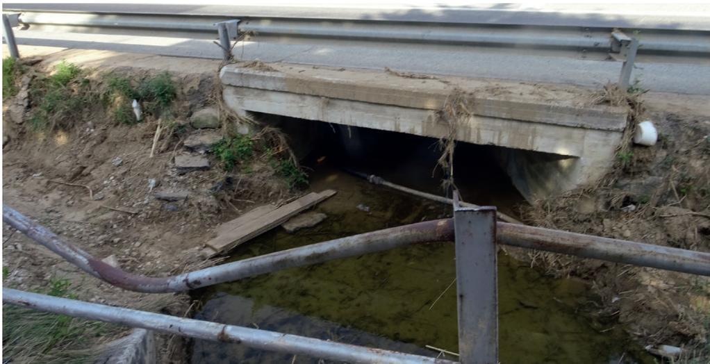
Figura 22. Daños en paso artificial en Pueyo (Navarra) por inundación (2019).
