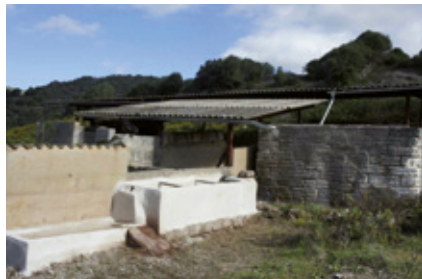
Estat de l'aljub i els abeuradors abans i després de l'actuació. S'hi pot apreciar l'abeurador arran de terra i les canals instal·lades
