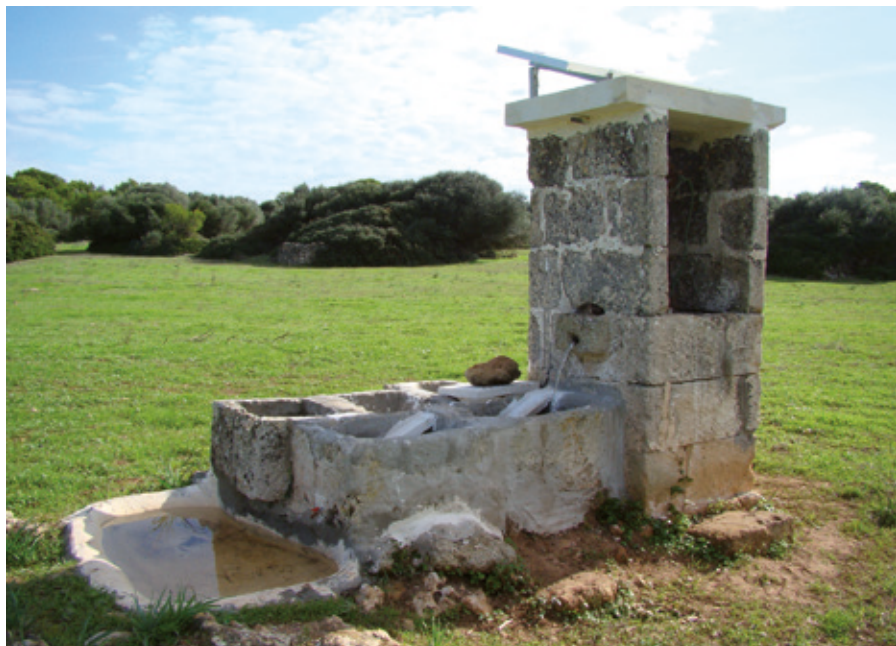
Abeuradors amb rampa i abeurador arran de terra. El nivell de l'aigua està controlat per boies. Amb energies renovables s'aconsegueix que estiguin sempre plenes.
