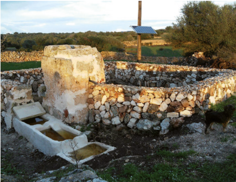
Aljub recuperat en el marc del programa de Custòdia Agrària del GOB Menorca. Inclou instal·lació de bombeig solar.
