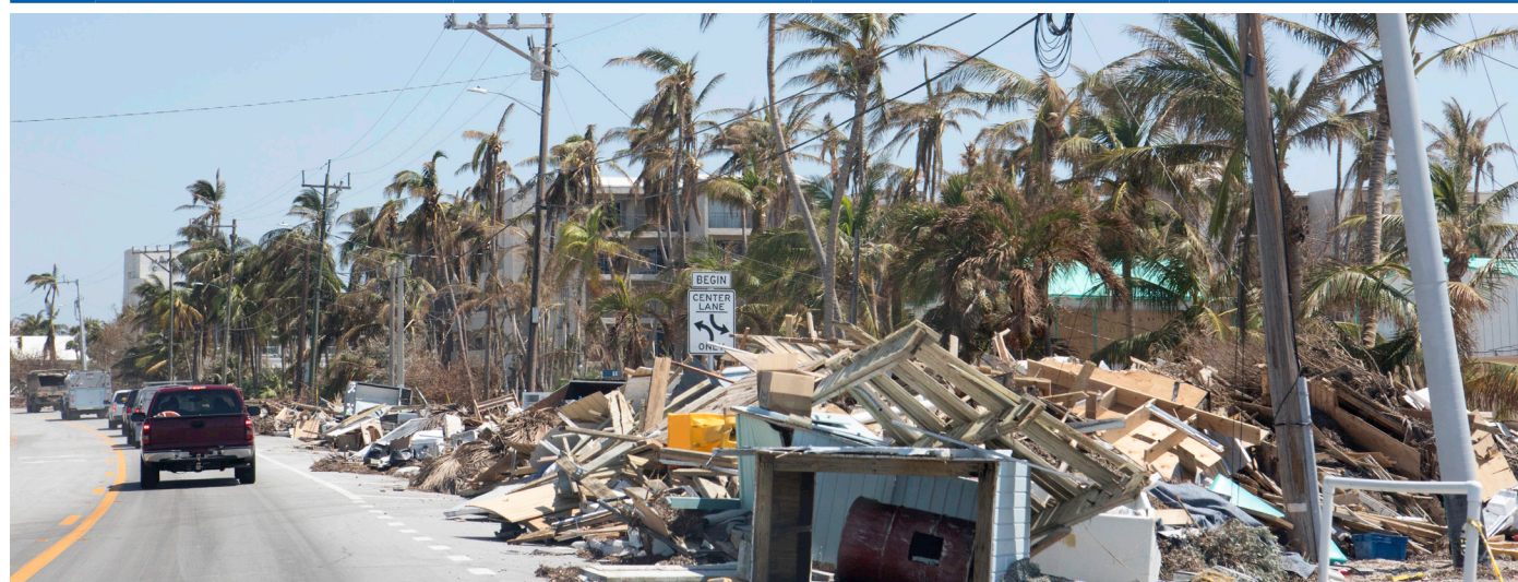
Crédito de la foto: Montones de basura y escombros en los Cayos de Florida tras el paso de un huracán. (Jodi Jacobson/iStock)
